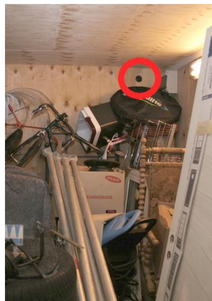
Tørluften blæses ind i containeren
